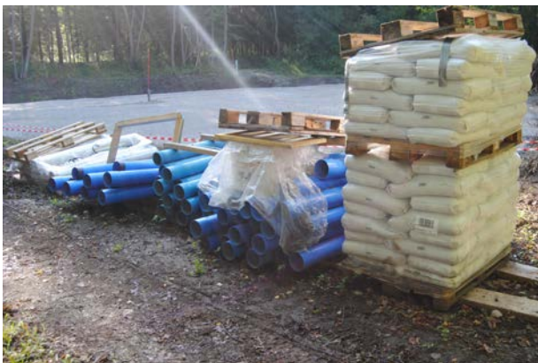
Die Bauarbeiten zu den beiden Brunnen wurden im September begonnen.
