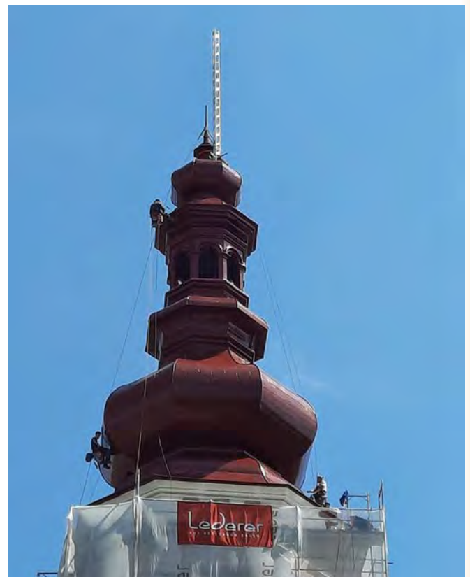
Gefährliche Arbeit in schwindelerregender Höhe
